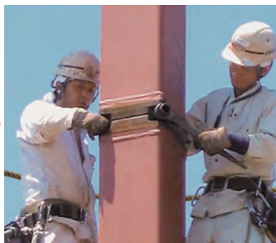
柱が転倒しない程度にナットを締め付ける
