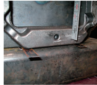
直角が出ていない場合はスペーサー等で調整する
