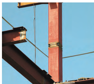
供回りの有無、ピンテールの破断、余長、ナットと座金の密着を確認する
