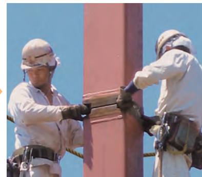
ボルトを引き出し、コラムカバーとコーナークリッパーをかみ合わせる
