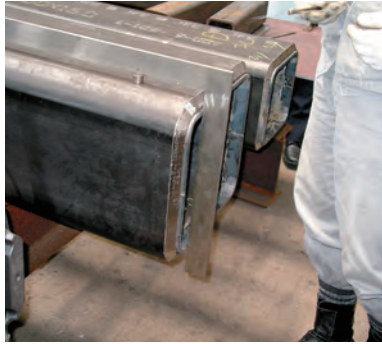
コラム裏当て金を取り付け、直角度を確認する
