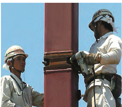
シャーレンチを用いて本締めを行う
