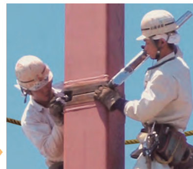
トルクレンチを用いて1次締めを行う
