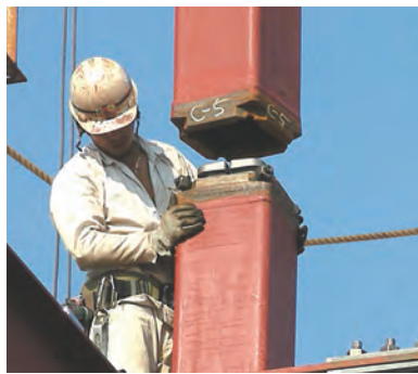
上階柱を下階柱に載せ、位置を合わせる
